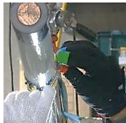
工程② 寸法出し削り
